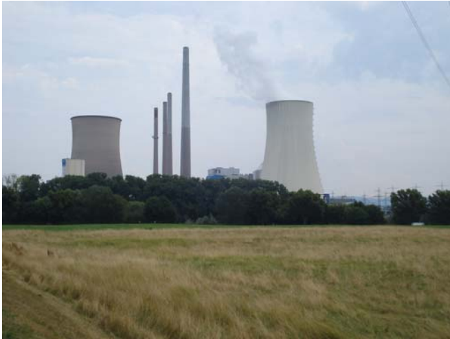
Abb.: Kraftwerkkomplex Staudinger
